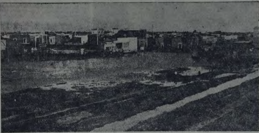
DE AVELLANEDA REVELAN, SIN EXCEPCION DE NINGUNA NATURALEZA, LA DESPREOCUPACION DE las autoridades comunales por la higiene y la vialidad, no obstante los altos impuestos que se cobran para atender los servicios municipales. La nota da idea del estado en que se encuentra una poblada zona de Geril, al lado del puente del ferrocarril Sud.
